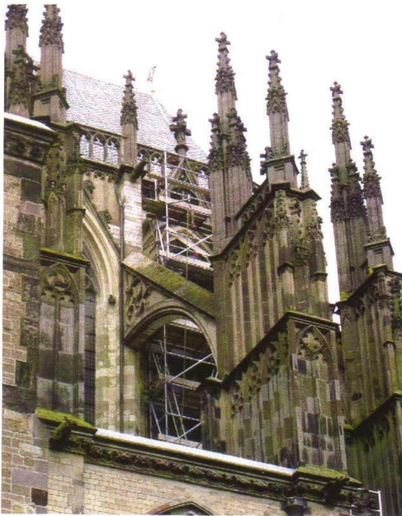
Rijk geornamenteerde natuursteenarchitectuur aan de zuidzijde van het hoogkoor
