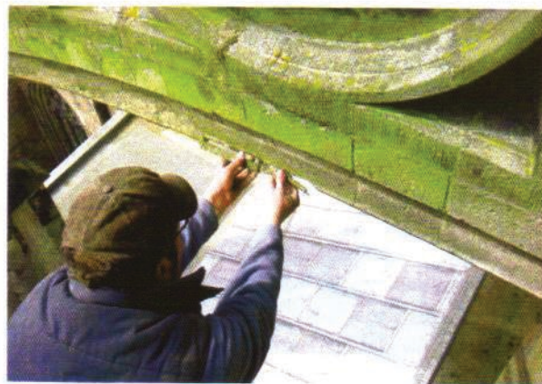
Gedeeltelijke vervanging tufstenen blokken in de luchtboog zuidgevel
