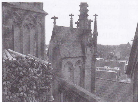
De zojuist weggehaalde steigers met uitzicht op de balustrade.
