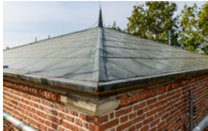
Foto boven: Het dak van de Oude Toren waarvan de hoeken hersteld moeten worden.
