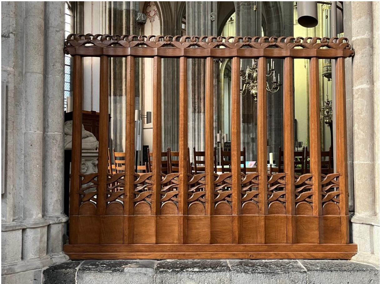
Afsluithek naar ontwerp Willem Penaat met snijwerk van Anton Fortuin op het Hoogkoor van de Domkerk gezien vanaf de noordelijke kooromgang, 1924-1925, gerestaureerd 2024
