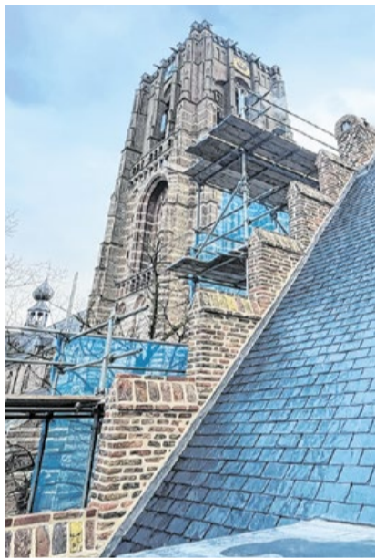
Het gerestaureerde dak van het Oude Raadhuis te Oirschot aan de linker achterzijde met trapgevel, ezelsruggen en schoorsteen met op de achtergrond de toren van de Sint-Petrusbasiliek.
