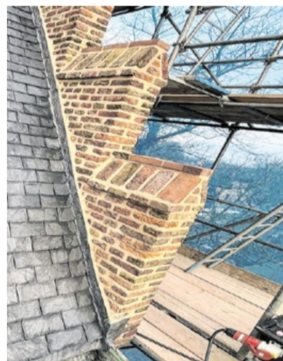
Restauratie van het steen- en voegwerk van de trapgevel en de ezelsruggen aan de rechter voorzijde.
