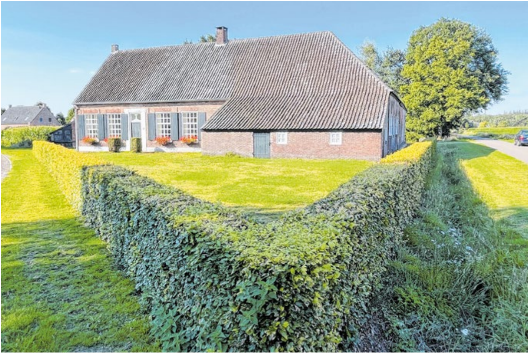
De voormalige boerderij aan de Putstraat 10 in Middelbeers – een gemeentelijk monument - ontving mede in verband met de transformatie naar wonen gemeentelijke ondersteuning voor de monumentale instandhouding van de gevels.
